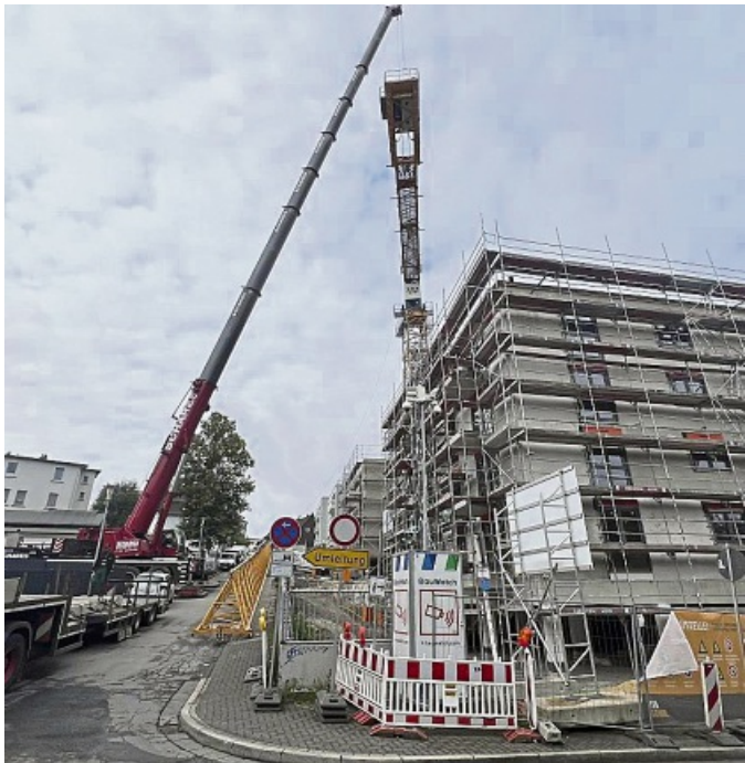
Gigant am Haken: Ein 32-Tonnen-Teleskopkran ist für den Abbau nötig. CÉDRIC OLIVIER NOUGRIGAT
