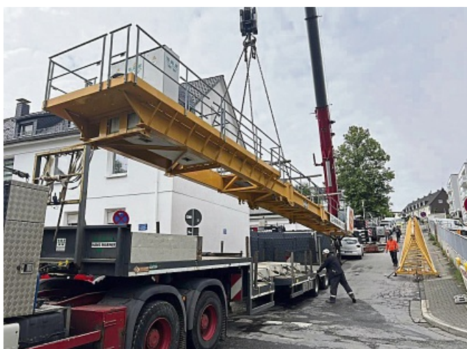
Der Großkran mit einer Hakenhöhe von 32 Metern wird mit insgesamt neun Lkw abtransportiert. CÉDRIC OLIVIER NOUGRIGAT
