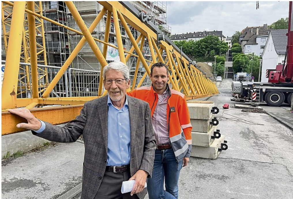
Projektentwickler Roland Rothmann und Roel Joosten (Ten Brinke) machten sich ein Bild vom Baufortschritt. CEDRIC NOUGRIGAT
