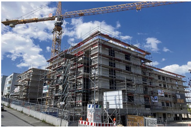
Erst vor einem halben Jahr wurde die Grundsteinlegung gefeiert. FABIAN PAFFENDORF
